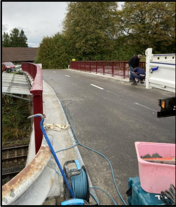
Remplacement du parapet du pont SNCF, route de Novillard, installé en 1970.
